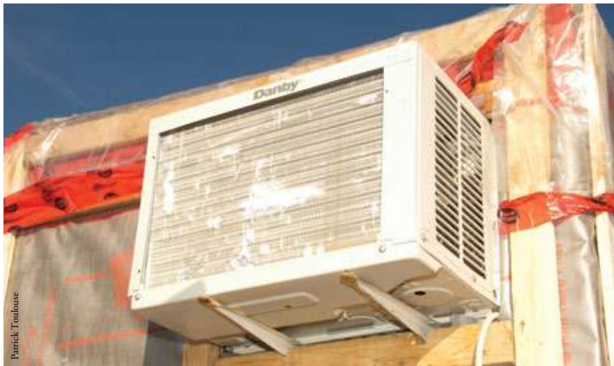
L'installation du climatiseur dans la chambre froide n'est pas très compliquée. Il faut percer une ouverture de la dimension requise pour y insérer le climatiseur qu'on fera reposer sur des supports auxquels il sera vissé pour être solidement retenu.
